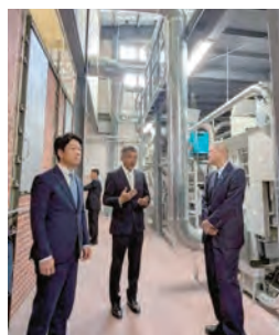
【4月18日】グリーンティ土山 てん茶工場竣工式
