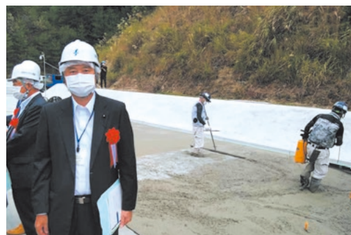
早期交通開放型舗装コンクリート施行見学会
